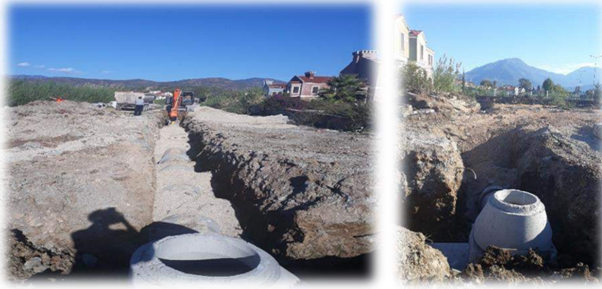
Fethiye İlçesi, Babataşı, Cami, Foça, Çatalarık Mahallelerinde Muhtelif Cadde ve Sokaklarda Yağmur Suyu Alt Yapı Tesis Yapımı
