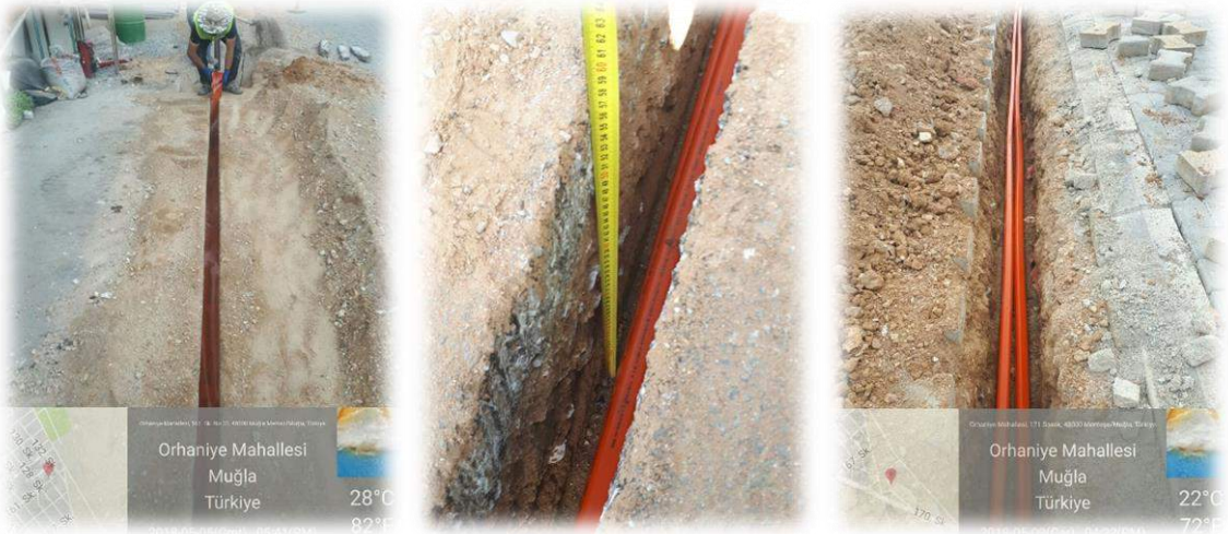
Menteşe İlçesi Fiber Optik Alt Yapı Tesisi Yapım İş
