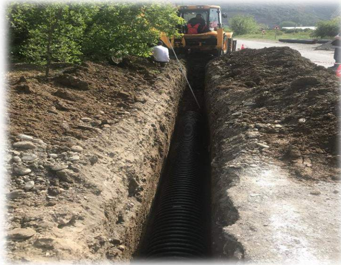
MUSKİ Genel Müdürlüğü Dalaman İlçesi Yağmur Suyu Alt Yapı Tesisi Yapım İşi
