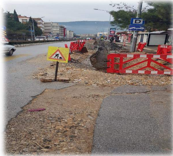
Menteşe İlçesi, Orhaniye Mahallesi, İsmet Çatak Caddesi Elektrik Yeraltı Kablolu Alt Yapı Tesisi Yapımı
