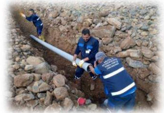
Boru Hattı Döşemesi (Köyceğiz ilçesi, Balcılar Mahallesi, Karacaağaç Mevkii)
