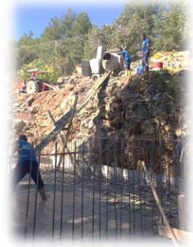
Sulama Havuzu Yapımı (Menteşe ilçesi, Yerkese – Yeniköy Mahallesi)
